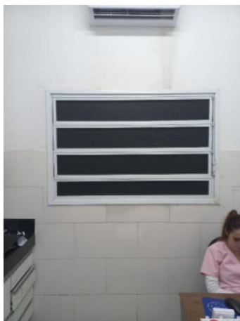
09/01 – Substituição tomada danificada copa
